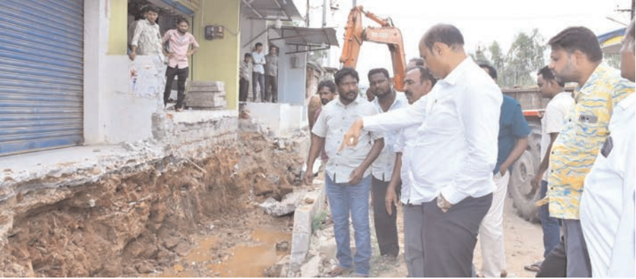
నా సాంత నిధులతో ఈ ప్రత్యేక డ్రైన్ ఏర్పాటు చేసినట్లు తెలియజేశారు. ఈ డ్రైన్ లో నిర్వహించే శానిటేషన్ పనుల నిర్వహణ పర్యవేక్షణకు ఒక్కొక్క
