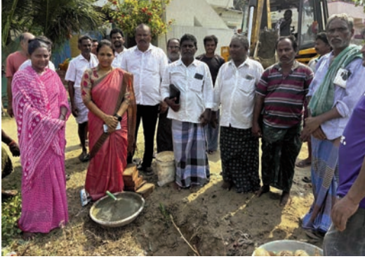
సిమెంట్ డ్రైనే పనులు కృత్తివెన్ను జడ్పీటీసీ మైలా రత్నకుమారి గ్రామస్థులతో కలిసి కొబ్బరికాయ కొట్టి సాంప్రదాయబద్ధంగా ప్రారంభించారు. ఈ సందర్భంగా జడ్పీటీసీ మాట్లాడుతూ.. గ్రామంలోని డ్రైనేజీ సమస్య పరిష్కారానికి ఈ నిధులు ఎంతగానో దోహదపడతాయని, నాణ్యతా ప్రమాణాలతో పనులను సత్కరమే పూర్తి చేస్తామని పేర్కొన్నారు. పాల్గొన్న ప్రముఖులు ఈ కార్యక్రమంలో గ్రామానికి చెందిన పెద్దలు, యువకులు మరియు పిల్లల సంఖ్యలో గ్రామస్థులు పాల్గొని హర్షం వ్యక్తం చేశారు.
