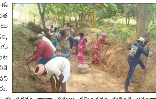
ధారణ పనులు చేస్తున్నామన్నారు. ఈ పని చేయడం వలన ఈ ప్రాంతం చెరువుకు నీరు రావడంతో పాటు అవులకు త్రాగు నీరు లభించడం, బోర్లు రీ-చార్జ్ కావడం జరుగుతుందన్నారు. అదే విధంగా పంట పొలాలుకు సాగు చేసుకోవడానికి సాగునీటి కొరత లేకుండా ఈ పని ఎంతో ఉపయోగపడుతుందన్నారు.
