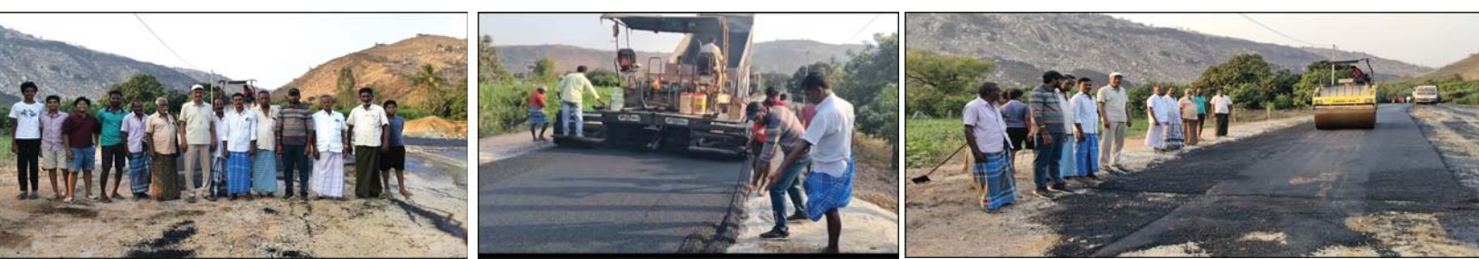
ప్రజా భూమి ప్రతినిధి, రామచంద్రపురం రామచంద్రాపురం మండలంలోని తాటి తోపు కండ్రిగ- నెన్నూరు గ్రామ పంచాయతీలకు అటవీ ప్రాంతం మధ్యలో ఉన్న గుండ్రోడు కణం రహదారిని మహాత్మా గాంధీ జాతీయ గ్రామీణ ఉపాధి హామీ పథకం నిధులు రూ. 3 కోట్ల రూపాయలతో నిర్మించి, తారు రోడ్డు పనులను పూర్తి చేశారు. స్వాతంత్ర్యం రాకముందు రహదారి సౌకర్యాలు లేక ప్రజలు గుండ్రోడు కణం కాలినడక దారిలో రాకపోకలు సాగించేవారు. తిరుమల శ్రీవారి దర్శనానికి వెళ్లేందుకు తమిళనాడు, ఉమ్మడి చిత్తూరు జిల్లాలలోని వివిధ ప్రాంతాల నుండి వచ్చే శ్రీవారి భక్తులు పూర్వం గుండ్రోడు కణం కాలినడక మార్గంలోనే నడిచి వెళ్లేవారు. తర్వాత శ్రీకృష్ణదేవరాయల రాయల చెరువు నిర్మాణం చేపట్టిన తర్వాత రాయల చెరువు మార్గంలో తిరుపతికి రహదారిని ఏర్పాటు చేశారు. వర్షాకాలంలో రాయలచెరువు వరద నీటితో నిండిపోతే రాకపోకలకు తీవ్ర అంతరాయం ఏర్పడేది. దీంతో తాటిమాకుల కండ్రిగ, కుప్పం బాదూరు, మిట్ల కండ్రిగ గ్రామస్థులు 2024 సాంస్కృతిక ఎన్నికల సమయంలో ప్రధానానికి వచ్చిన టీడీపీ ఎమ్మెల్యే అభ్యర్థి పులివెందుల వెంకటమణి ప్రసాద్ (నాని) గుండ్రోడు కణం రోడ్డు నిర్మాణం చేయించాలని కోరగా, కూటమి ప్రభుత్వం అధికారంలోకి వచ్చిన వెంటనే గుండ్రోడు కణం రోడ్డు నిర్మాణానికి రూ.3 కోట్ల రూపాయల సరేగా నిధులు మంజూరు చేయించారు.
