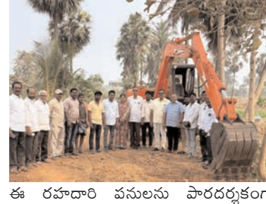
ఈ రహదారి పనులను పారదర్శకంగా
