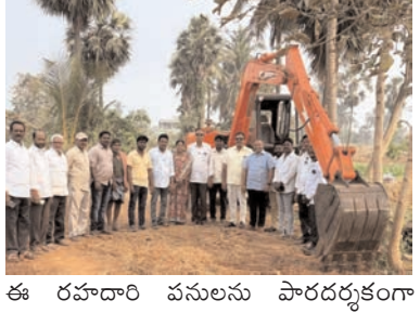
ఈ రహదారి పనులను పారదర్శకంగా
